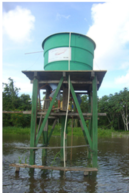
1b) Reservatório de água na época da cheia
