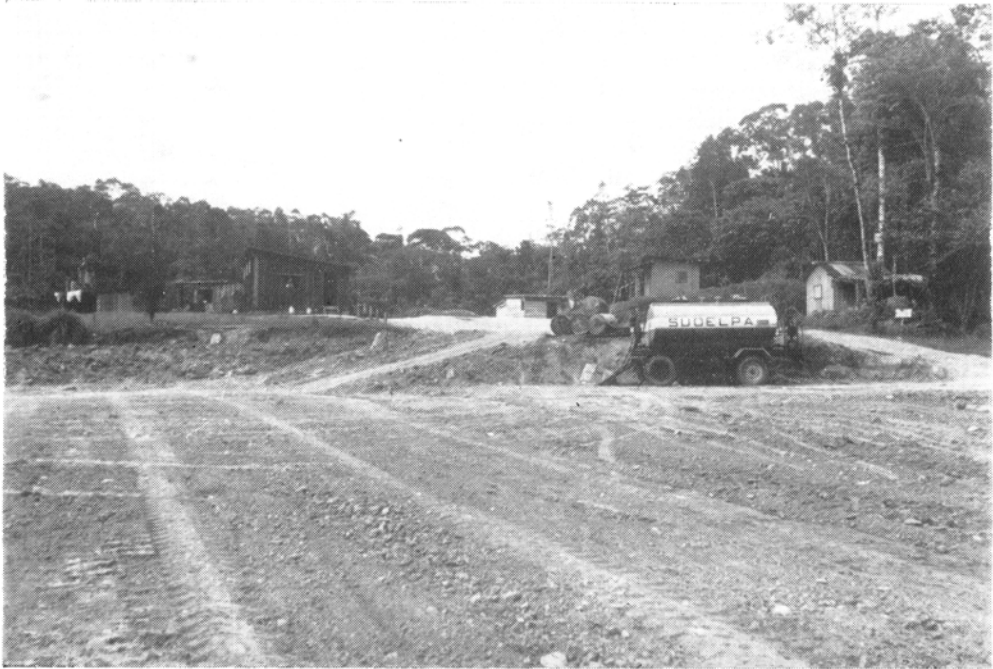
Fig. 10 — Acampamento da SUDELPA na construção da estrada de Ariri. Observa-se o aspecto transitório das construções roleadas pela floresta primária em níveis baixos.
