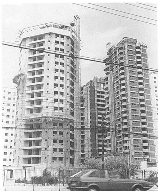
Figura 2 . Prédios de apartamentos, como exemplos de confinamento e monotonia
