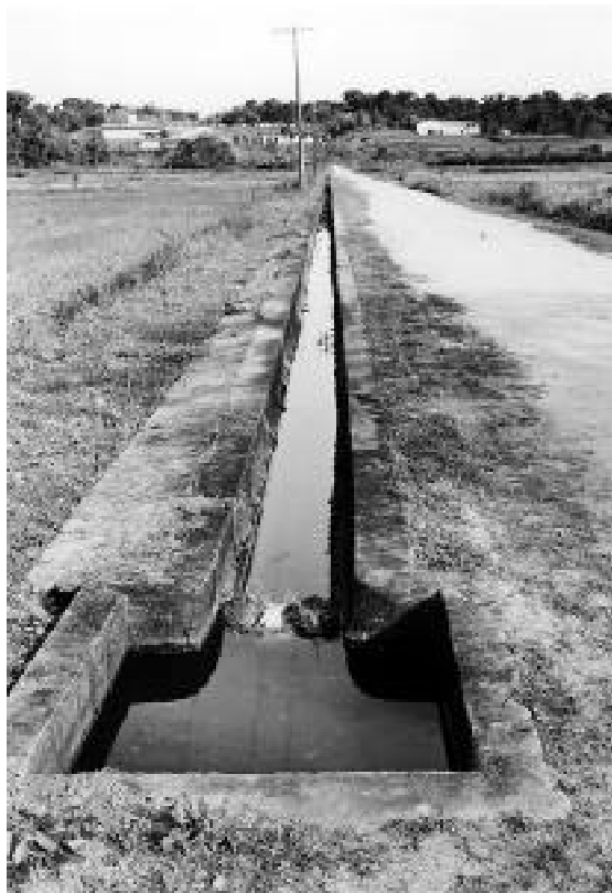
Figura 4 - Caixa d'água cimentada (Fazenda Experimental, Pariquera-Açu).
