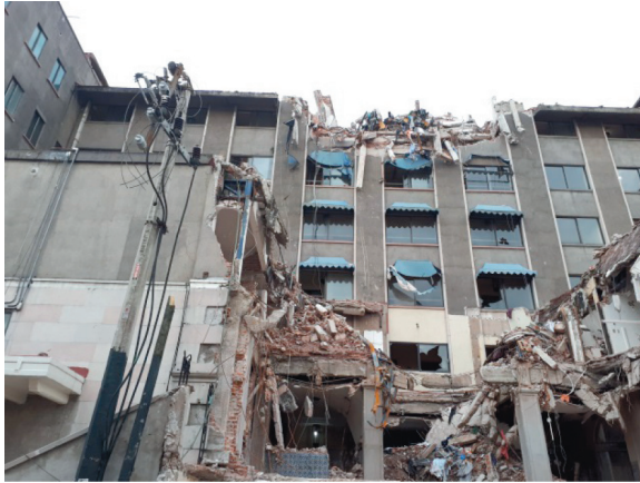
a) Edificio con más de 70 años de construcción
