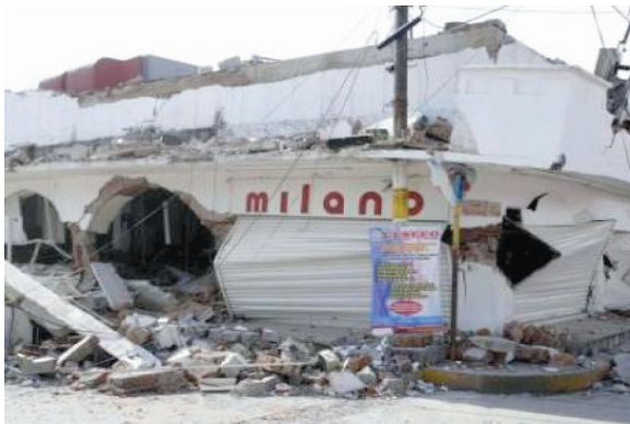
a) Estructura en esquina
