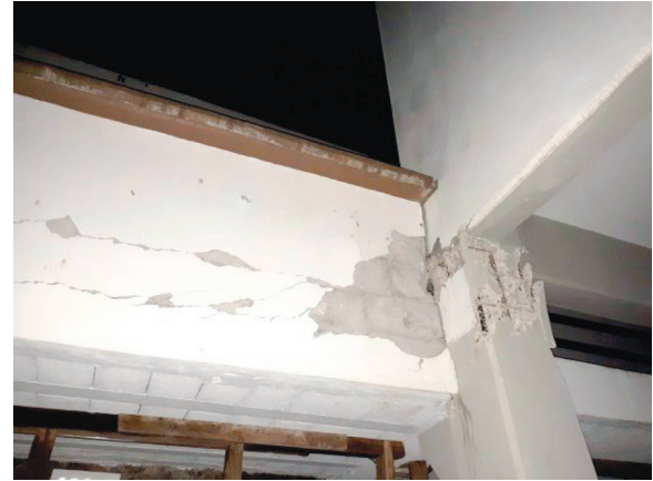
b) Edificio con menos de cinco años de construcción
