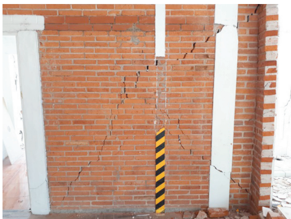
FIGURA 15. MUROS DE CARGA CON FALLA POR CORTANTE
