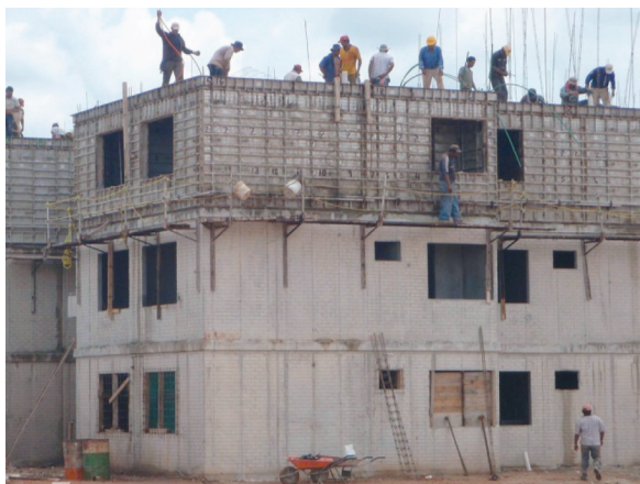
a) Construcción de departamentos
